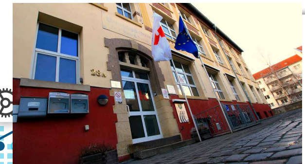
Schulhaus Kochstrabe 28a, Südvorstadt
